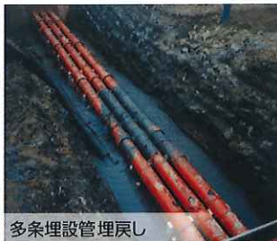
地下構造物の充填
