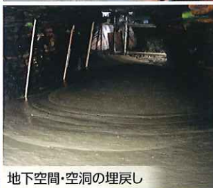
多条埋設管埋戻し
