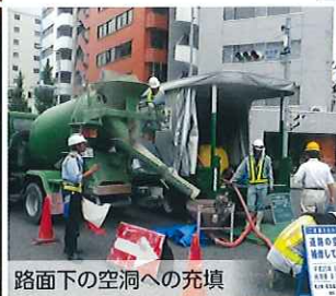
地下構造物の充填
