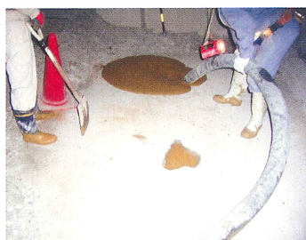
地下構造物の充填
