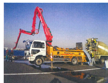
護岸空洞への充填
