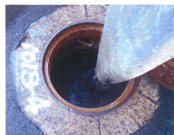
不要になった休止管の閉塞
