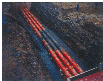
多条埋設管埋戻し
