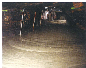
地下空間・空洞の埋戻し
