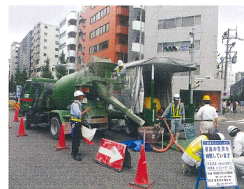
路面下の空洞への充填
