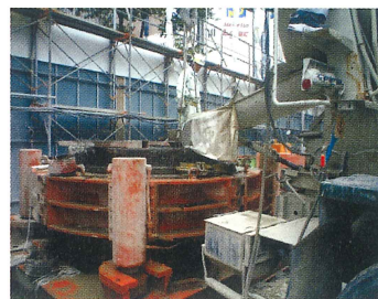
杭撤去後の仮埋戻し
